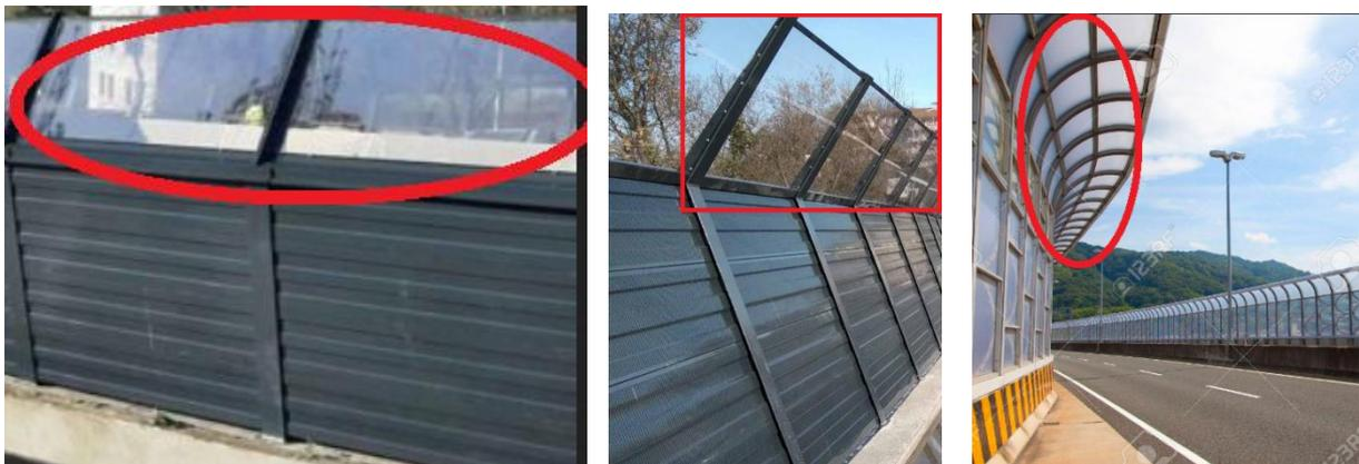
Ejemplos de paneles en cuya cúspide se incorpora un componente de efecto envolvente
